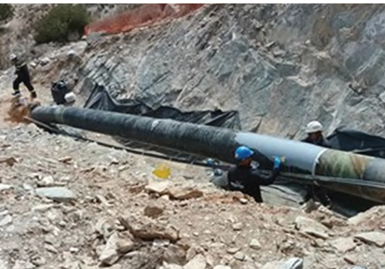
• Recubrimiento anticorrosión, Belzona 5811 (grado de inmersión), aplicado a la tubería.
