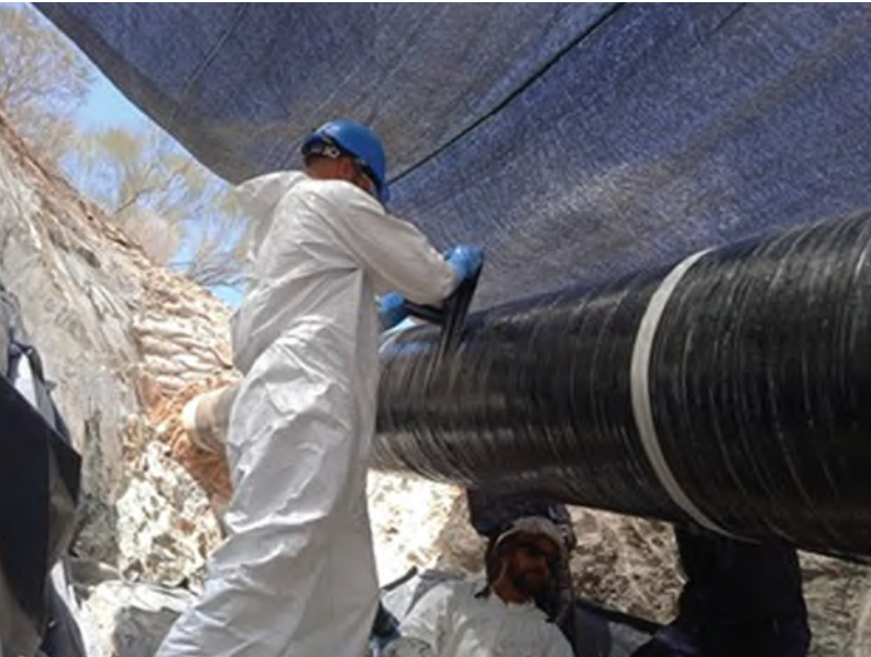
• Aplicación de una envoltura compuesta, Belzona SuperWrap II, a la tubería de acero.
